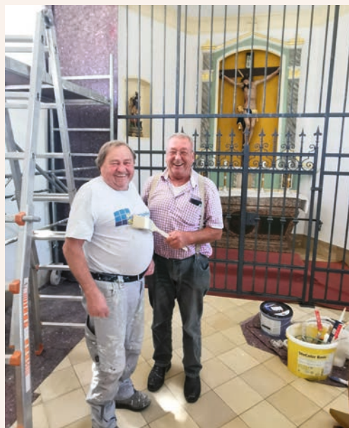
Karl Heinz Denk und Georg Kirzinger bei den Renovierungsarbeiten
